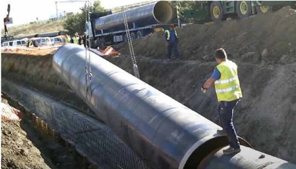
Obras del segundo anillo de distribución del Canal de Isabel II Canal de Isabel II
