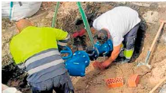
Montaje de válvulas en la avenida de la Constitución. SUR
