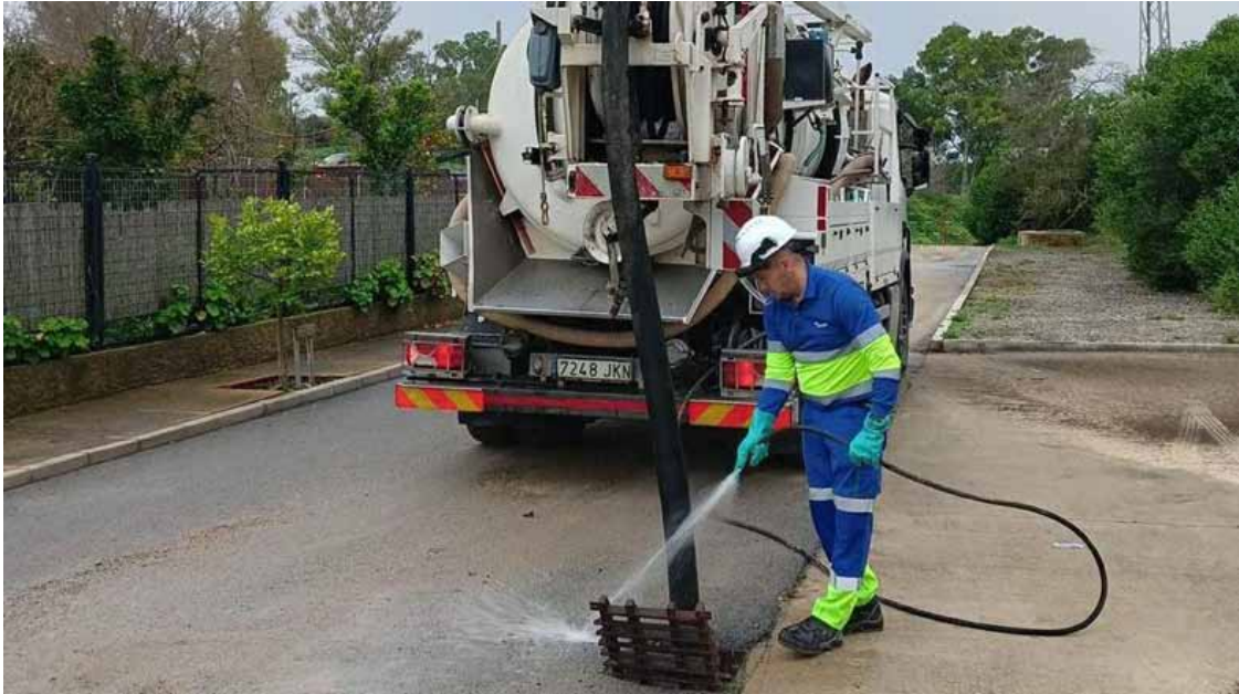
Limpieza de imbornales, ante la previsión de fuertes lluvias.
