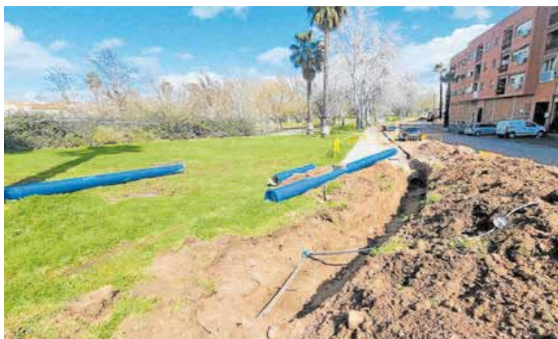
Obra de la canalización del subsuelo en María Auxiliadora. J. M. ROMERO
