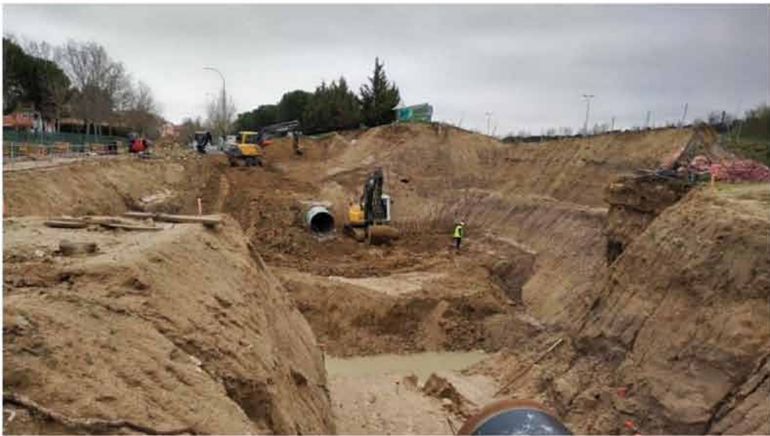
Obras del segundo anillo de distribución del Canal de Isabel II
