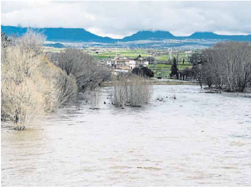
El Ter, a su paso por Manlleu
