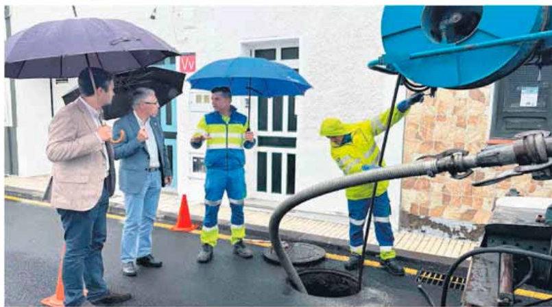
LA LIMPIEZA DEL ALCANTARILLADO EN DIVERSAS CALLES ES UNA DE LAS MEDIDAS PUESTAS EN MARCHA. D.A.
